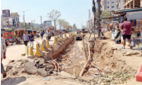
డ్రైనేజీ ఏర్పాటుకు తవ్విన రోడ్డు
